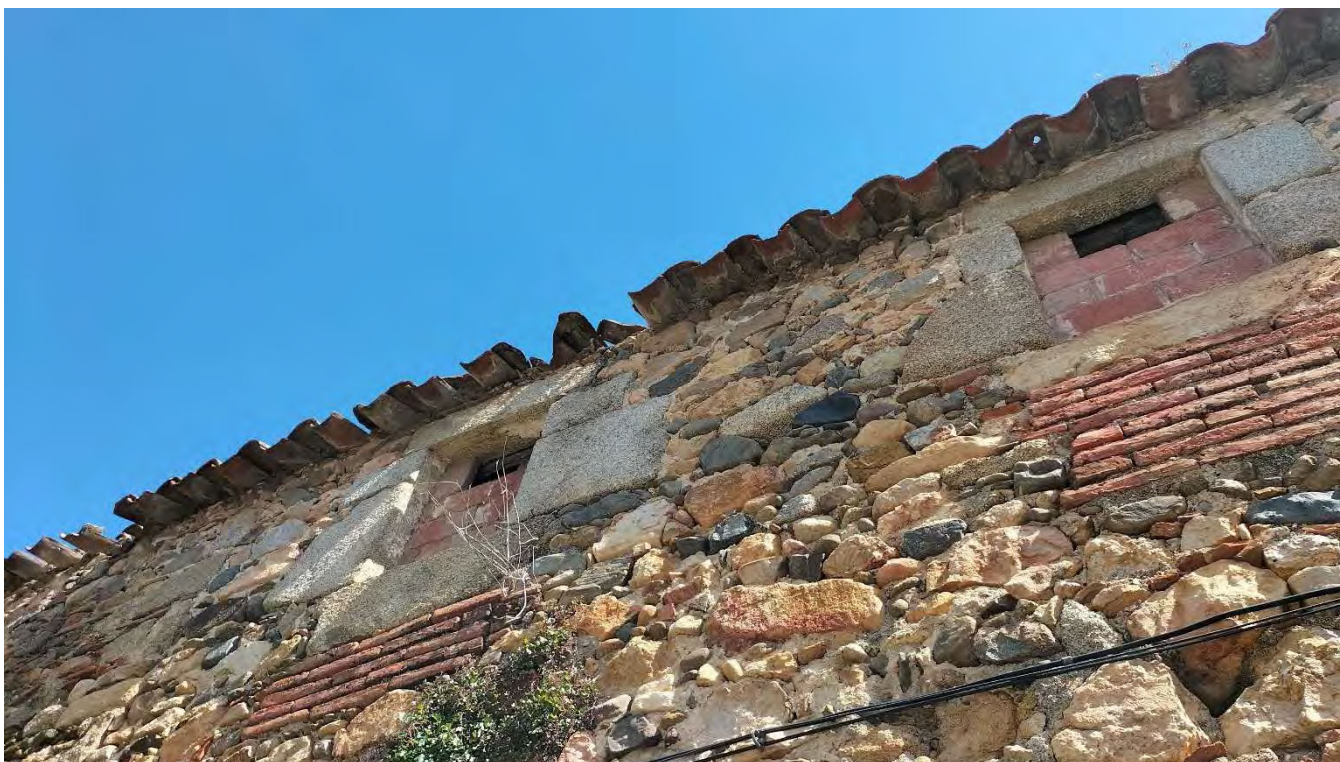
Detall de la trobada entre façana i coberta
