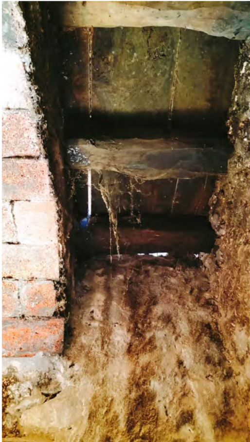
20: Forjat sobre àmbit accés
